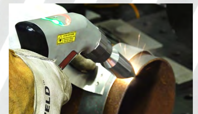
Высокопроизводительный режим очистки до и после сварки
